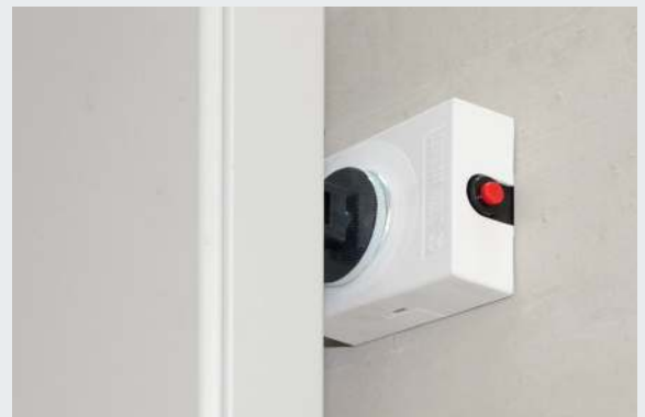
90° Offenstellung mittels Haftmagnet
