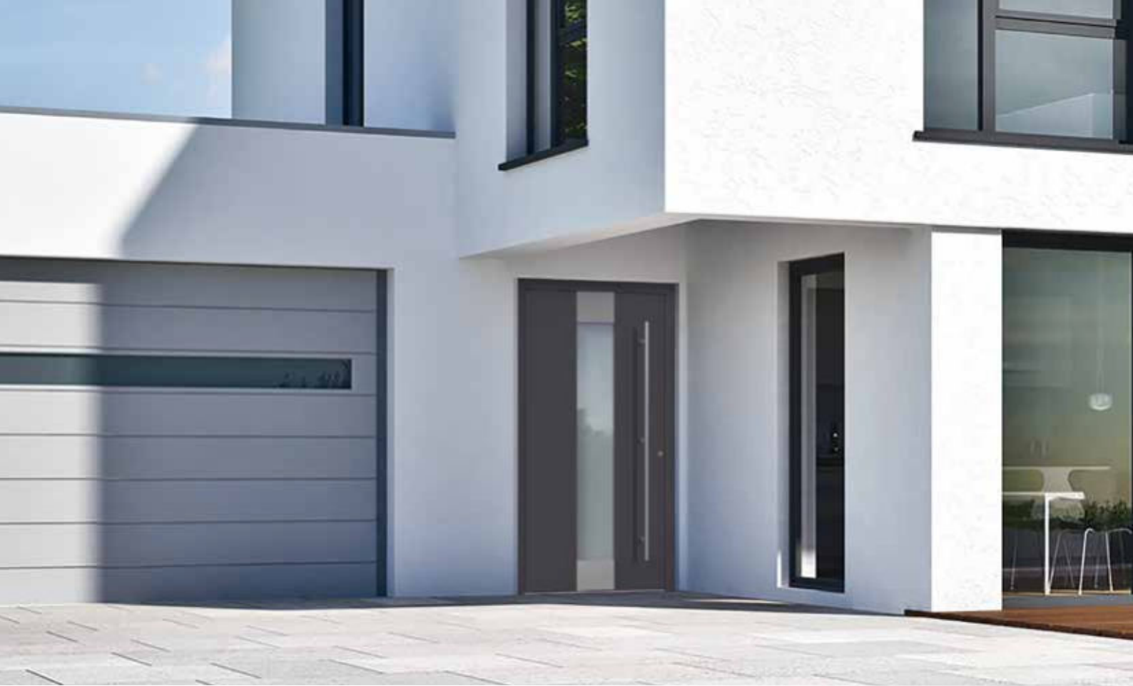
Hauseingang: DB 703 Eisenglimmer FS
