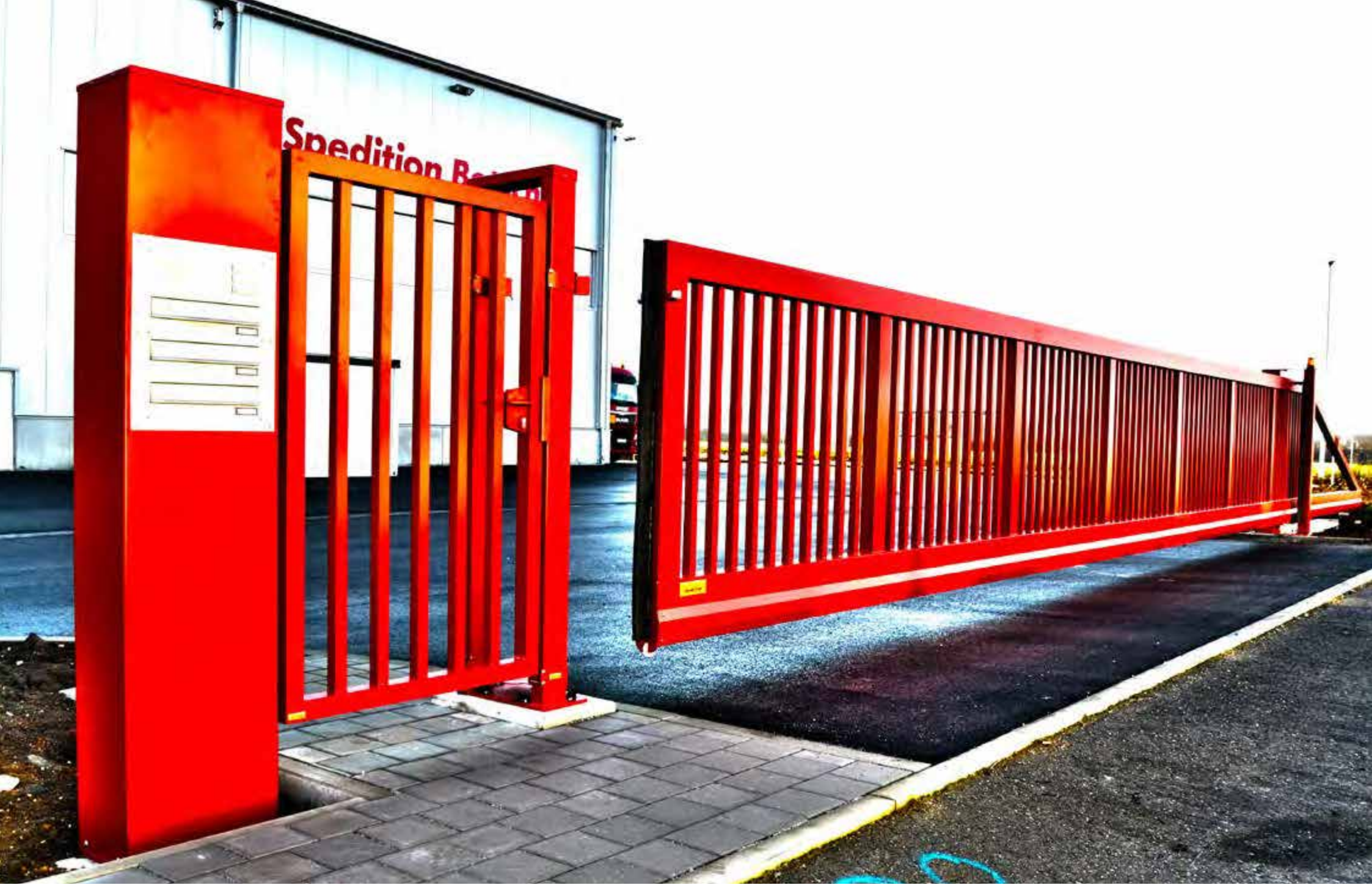
Profiline Schiebetor mit Personentür und individueller Briefkastensäule mit Sprechanlage
